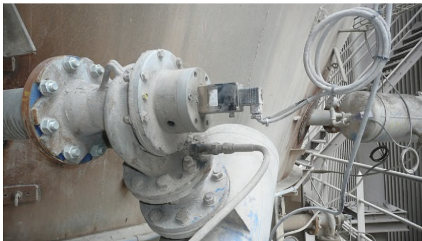
Origineel ventiel op Standard Industrie luchtkanon
